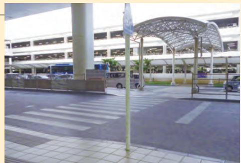
國內線區域1F北側步行道出入口④附近
